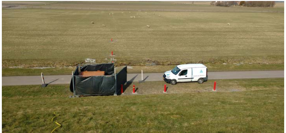
Uitvoering pompproef. (Bron: Wiertsema & Partners)
